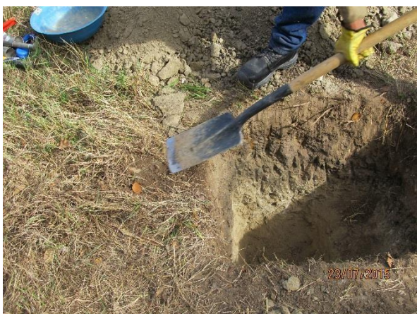
Foto 2. Eliminación de la capa vegetal.
